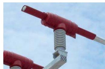
2 x MVLC-38 na přípojnici spolu s BCIC krytem
