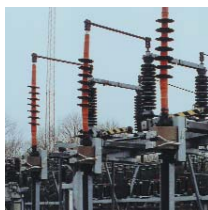
Teplem smršťitelné koncovky do 72 kV
