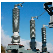
Kompozitní venkovní koncovky pro plastové kabely do 170 kV
