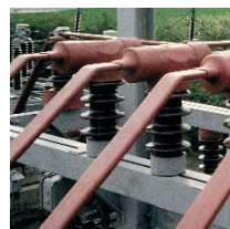
Systém izolování přípojnic
